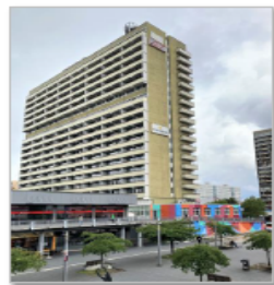
Hauptgebäude mit Tagungsraum Neustädter Passage 6
